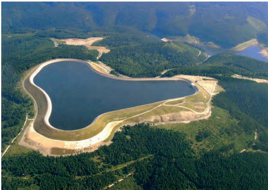
Figure 2-2 – Pumped Hydro Storage (Vattenfall, IEC MSB/EES Workshop, 2011)
